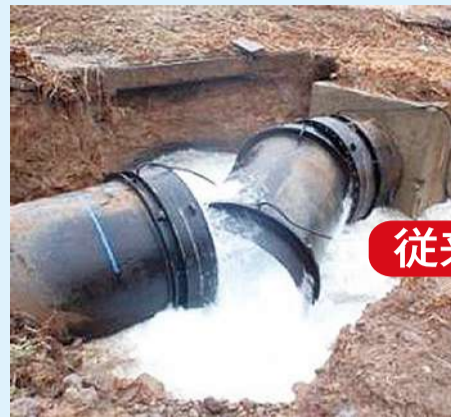
*写真は、東日本大地震で、継ぎ目が外れた従来管と津波にも耐えた耐震管(出典/宮城県企業局・仙台市水道局)
